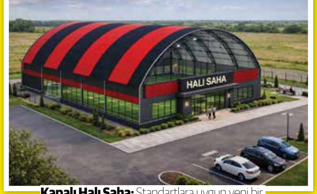
Kapalı Halı Saha: Standartlara uygun yeni bir kapalı futbol sahası inşası.
